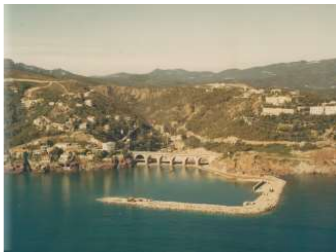
Début de la construction du Port de la Rague.
